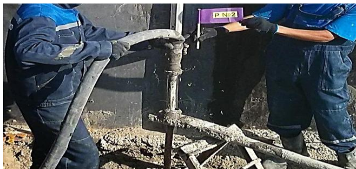
Рисунок 1 - Нагнетание уплотняющего раствора в грунт
